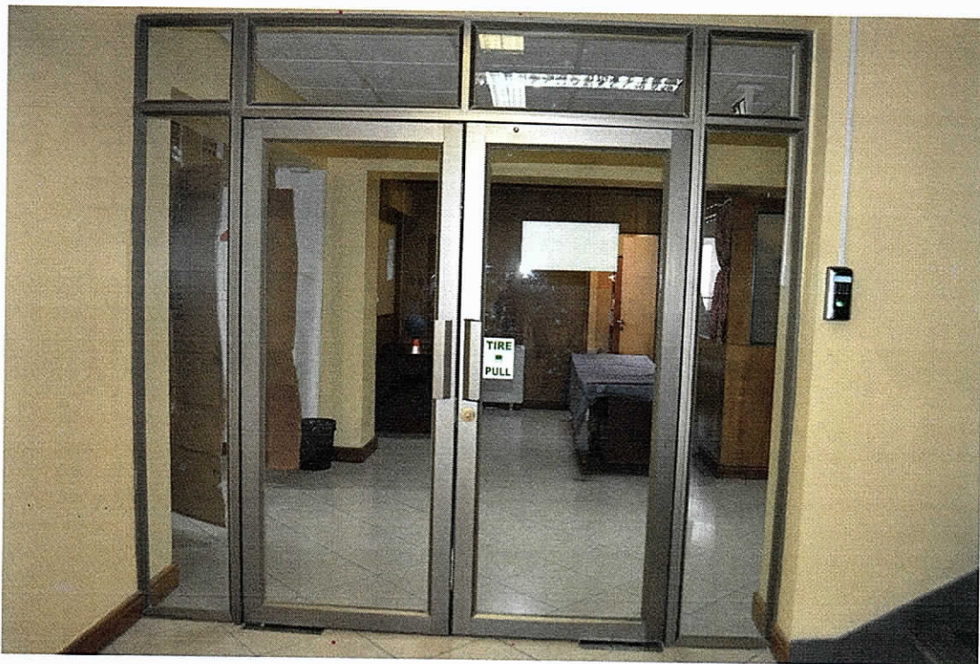
Imagen de mampara de acceso al piso 5 del edificio
