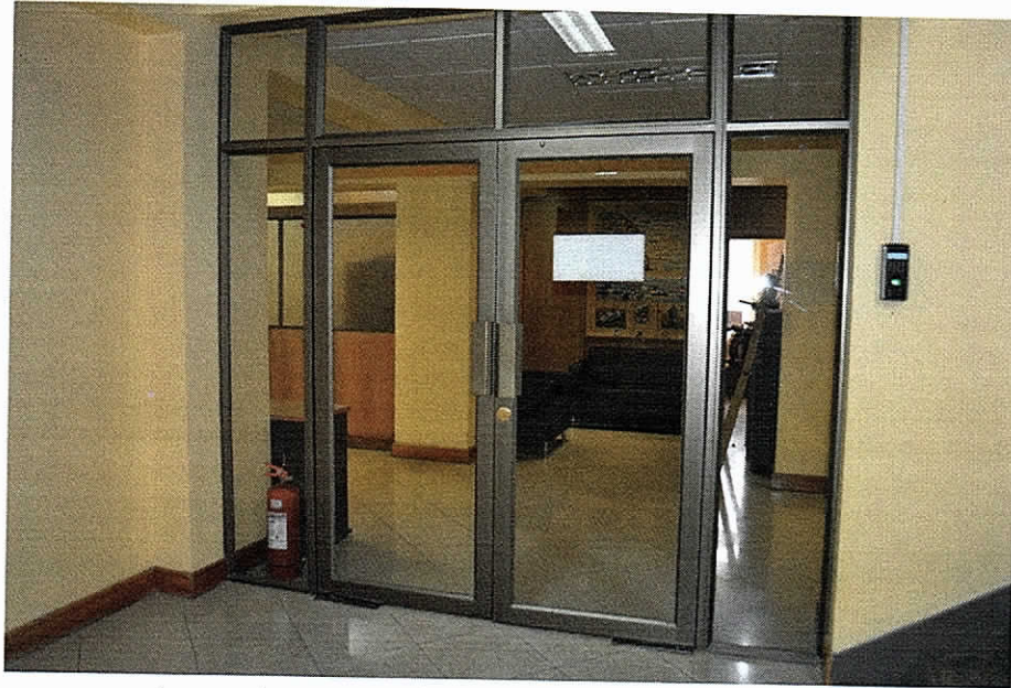
Imagen de mampara de acceso al piso 4 del edificio
