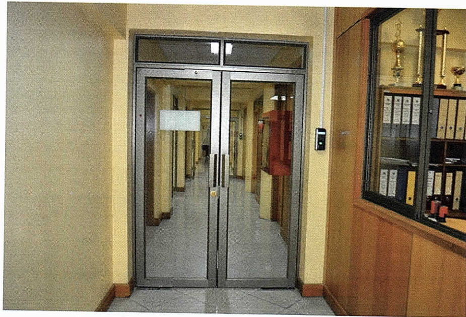
Imagen de mampara de acceso al piso 3 del edificio
